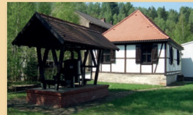
Gebläsehaus mit Resten der Wasserturbine Foto: Roland Kowar
